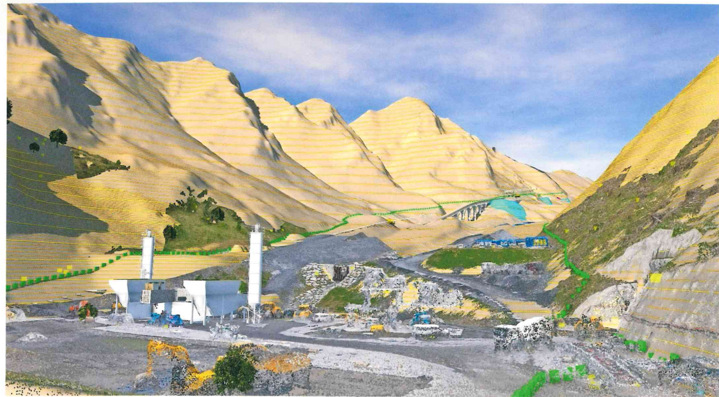
MAMMUTPROJEKT Die Porr realisiert aktuell das Baulos „H51 Pfons-Brenner“, den größten Bauabschnitt des Brenner Basistunnels. Hier als grobes Geländemodell mit integrierten Photogrammetrie-Daten und Informationen aus einer digitalen Punktwolke.
