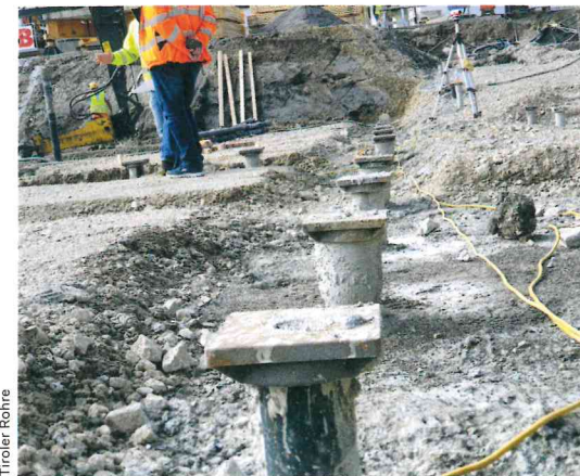
GRÜNDUNG Im Tiroler Tannheimertal entsteht gerade ein zweistöckiges Seniorenheim, welches auf „sicheren Füßen“ von TRM zu stehen kommt.
